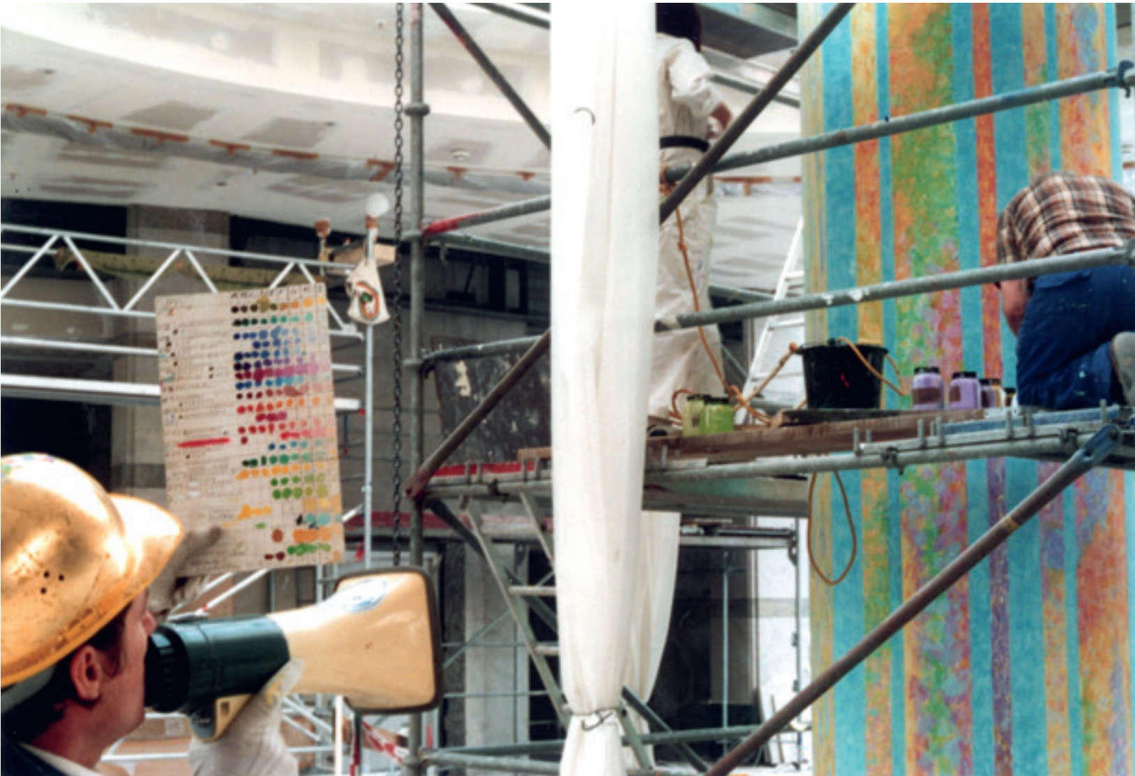
Horst Gläsker mit Farbtabelle und Megaphon, auf dem Gerüst Stuckateur Eduard Kneitz
